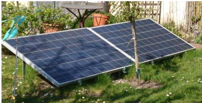
Bild: Steckermodul-Geräte in einem Roßdorfer Garten mit ertragsminderndem Schatten, Foto C. Nintzel
